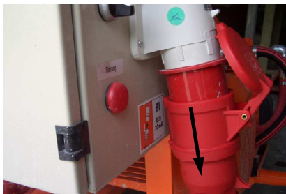
Рис. 73: Демонтаж соединительного кабеля
