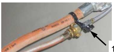
Рис. 49: Открытие воздушного крана
