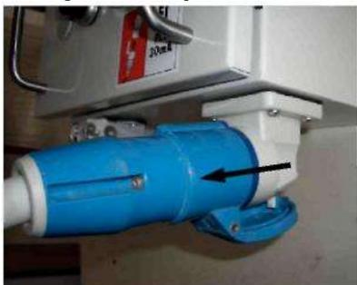
Рис. 39: Удалить подключающий кабель
